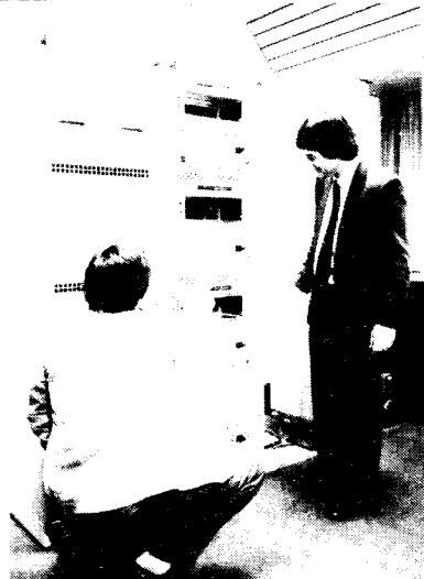
Technikraum im BR-Hochhaus: Von hier aus werden evtl die ersten drei Frequenzen für Privatfunk in Betrieb genommen.
